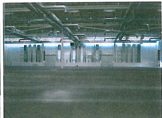
5 Innenansicht Messehalle A1
