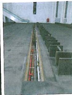
7 Spartenkanal zur Medienversorgung © Ingenieurgesellschaft Ridder Meyn Nuckel (Abb. 4–7)
